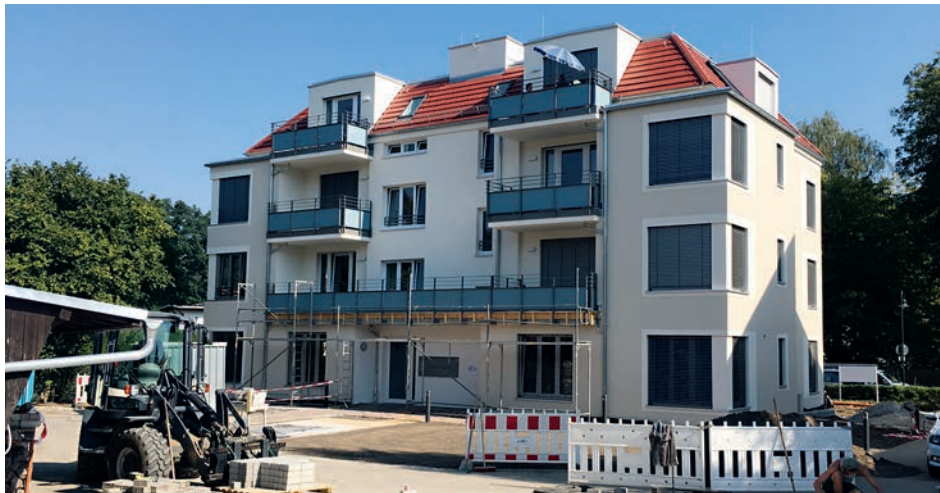
Die Wohnanlage kurz vor der Fertigstellung im August
