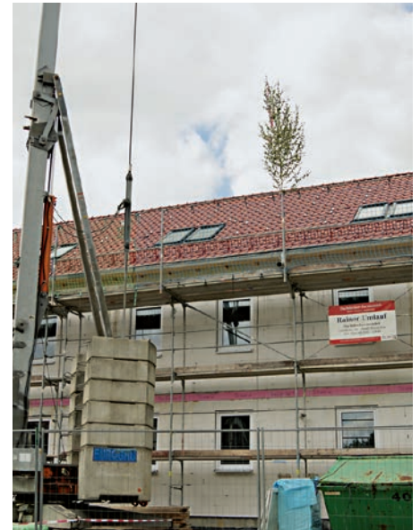
Richtfest am 12. August 2016
